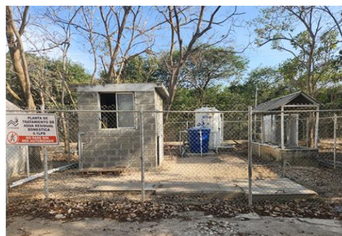
Ilustración 90. Planta de tratamiento de aguas residuales capacidad 0,12 LPS
