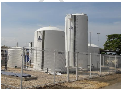
Ilustración 89. Planta de tratamiento de aguas residuales capacidad 1,12 LPS
